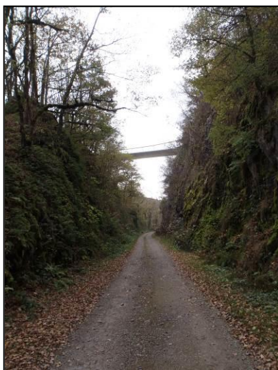
Figure 19 : Ancienne voie ferrée dans la vallée du Chavanon
